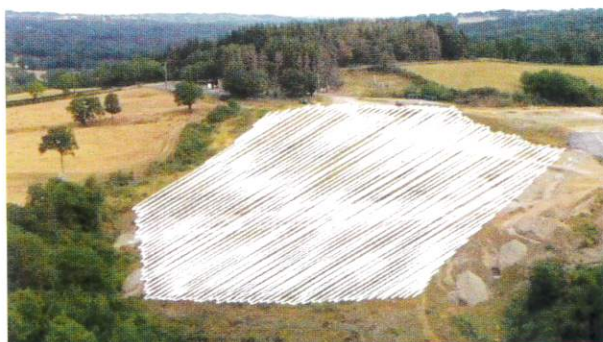
MIREMONT : 2 hectares dédiés à la centrale photovoltaïque
