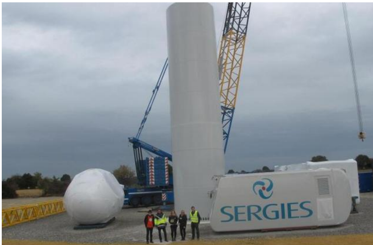
Les monumentales éoliennes vont être montées pour être mises en service en novembre. - (Photo Loïc Lejay)
