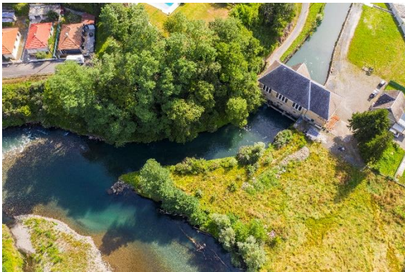
La centrale de Latour (©Envinergy)
