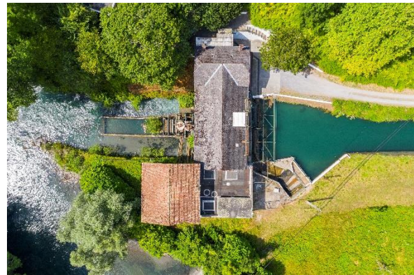
La centrale de Vizens (©Envinergy)
